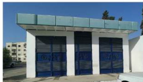
07 محطة تحويل جهد كهرباء 0.4 / 11 ك. ف
