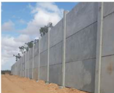
08 إنشاء سياج من الخرسانة مسبقة الصب بارتفاع 6 متر
