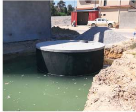
01 خزان مياه في منطقة ذات منسوب مياه جوفيه مرتفع
