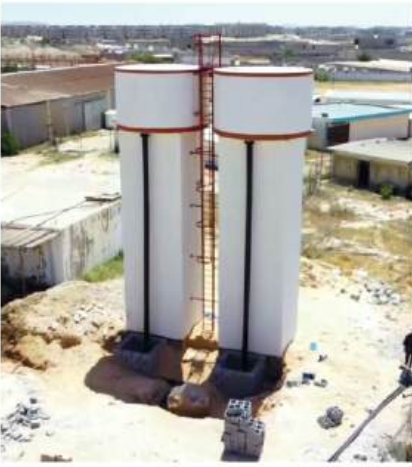
02 خزان علوي بارتفاع 9 متر بمخيم الزروق
